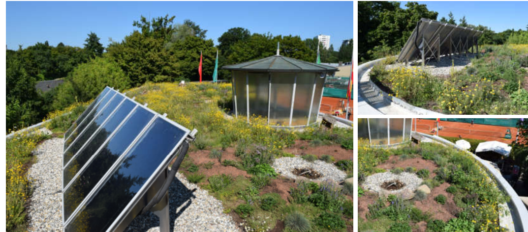
Solar + Biodiversity on Green Roofs | M. Sc. Fiona Wolff, Bundesverband GebäudeGrün e.V. (BuGG) | European Green Premises (EGP 2022) | Wiesbaden 15.09.2022
