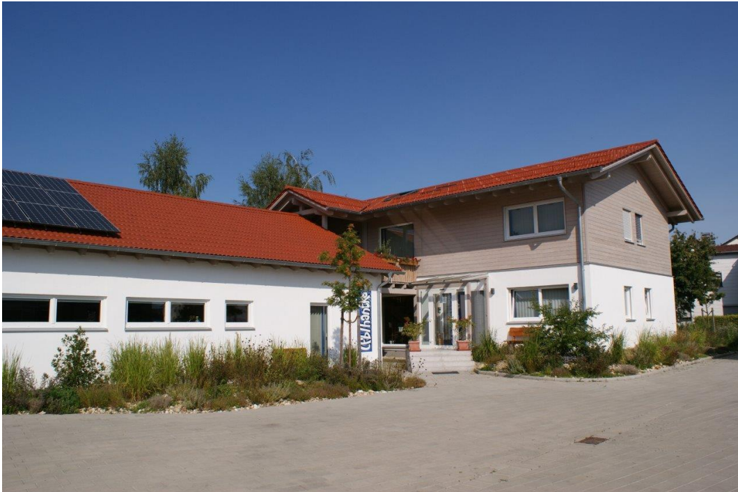
Abb. 4: Neubau des Werkstofflabors Hantke in Strasskirchen. Die Außenanlagen wurden biodivers angelegt.
