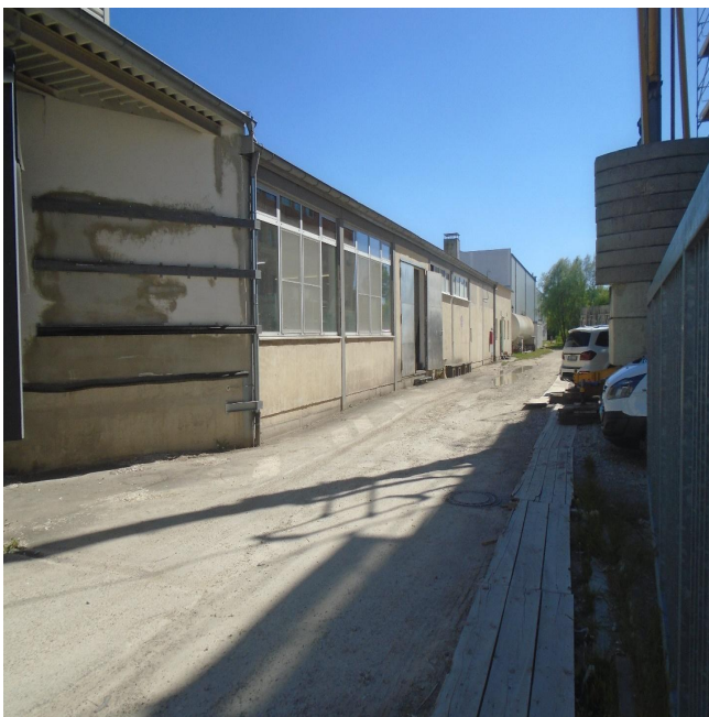
Abb. 2: Auf diesem trostlosen Betriebsgelände verbringen die Mitarbeiter und Mitarbeiterinnen ihre Pausen. Man beachte die Bank am Gebäude.
